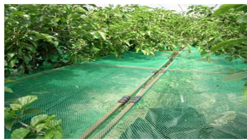
오디 수확장치 설치
